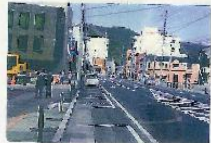
次々と解体が進む市街地（釜石市東北電力支店付近）
